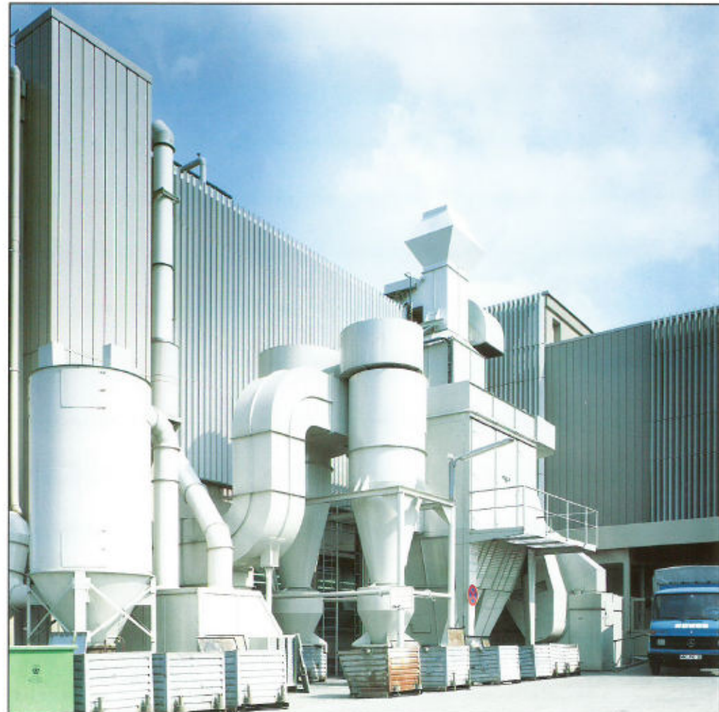
Nach der Fassaden-Neugestaltung
