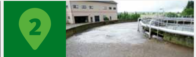
Ausbau der Sammelkläranlage Öhringen in Baden-Württemberg
