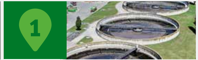
Neubau der Kläranlage Westerburg in Rheinland-Pfalz
