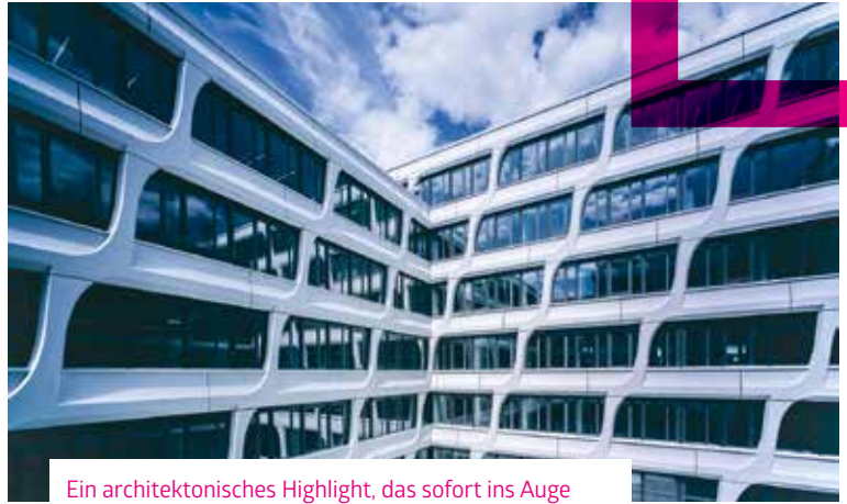
Ein architektonisches Highlight, das sofort ins Auge fällt, ist die weiße, vorgefertigte Fassade, die die Formbarkeit, Vielseitigkeit und Ästhetik des Materials Beton sichtbar macht.
