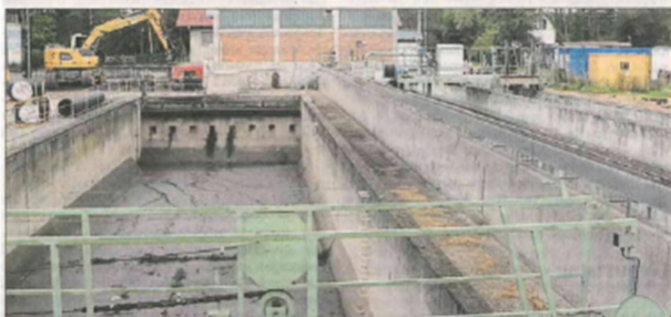
Nach der ersten Klärstufe im Rechenwerk (hinten) wird im nächsten Becken (rechts) das Absinken der Sand- und Schwabestoffe erreicht. Links das Rückhaltebecken für Starkregenereignisse, das beim Un-
