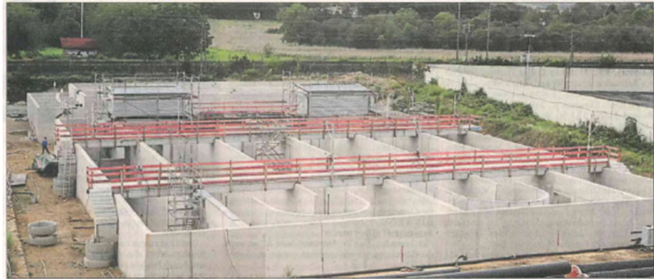
Der Neubau schreitet voran, hier ist die neue biologische Stufe der Klärung im Rohbau zu sehen. Bis zur Inbetriebnahme werden aber wohl noch zwei Jahre vergehen. Foto: gus
