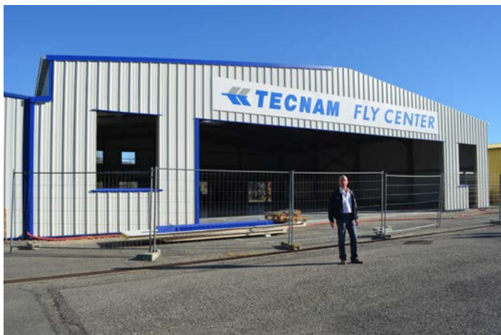
Le bâtiment relais construit pour accueillir le nouvel atelier de maintenance de la société TECNAM
