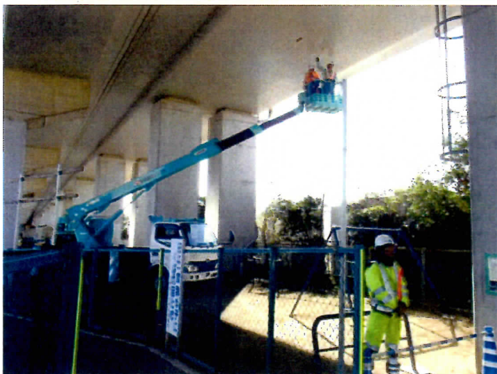
高所作業車を使用した橋梁点検事例
