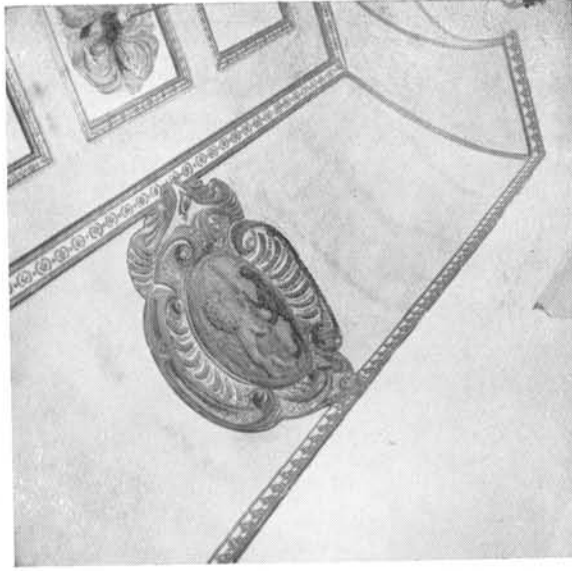
Techo de la Capilla
