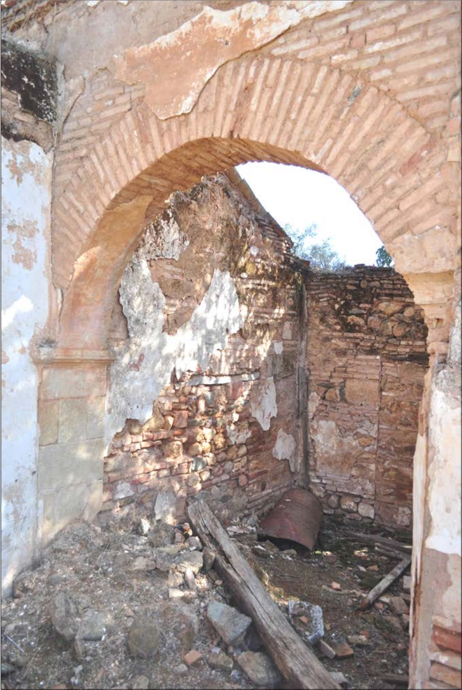
Fig. 6. Arco de nave lateral (2012-10-03).
