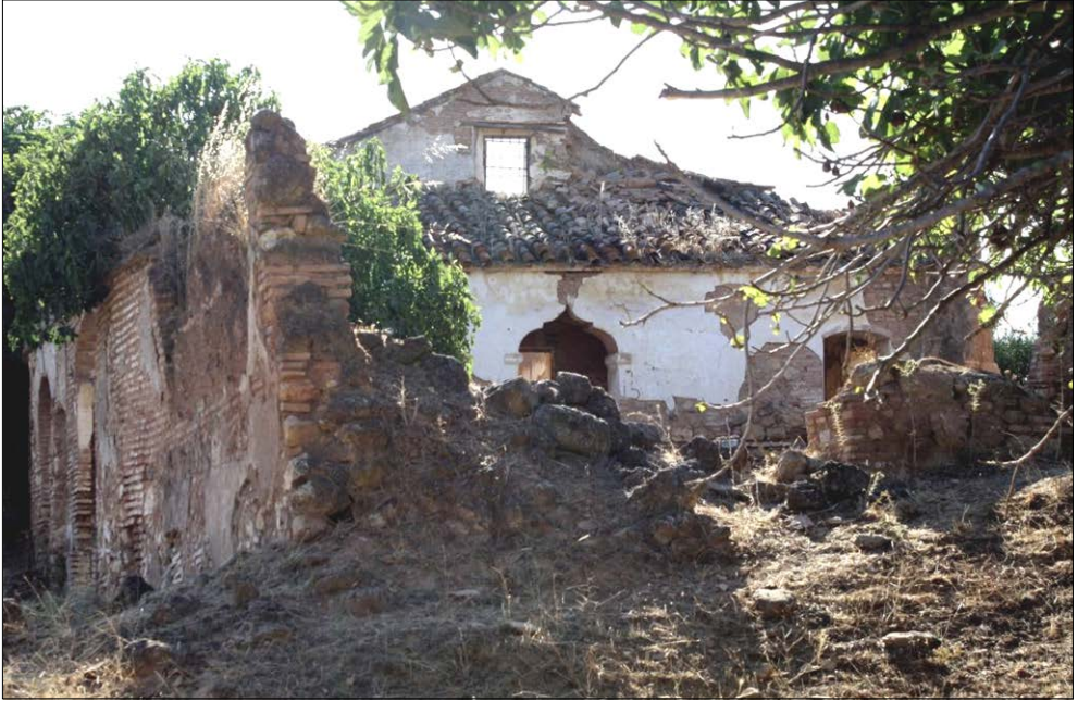
Fig. 2. Acceso por su cara este (2009-06-29).
