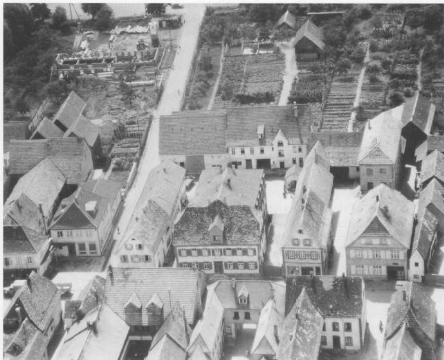
Herxheim im Jahr 1957: Im Vordergrund das St. Josefsheim; weiter oben das im Bau begriffene neue Rathaus (Foto: VG-Archiv Herxheim)
