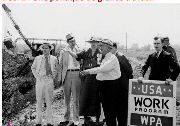
En visite sur un chantier dans l'Iowa, Eleanor Roosevelt, l'épouse du président Franklin Delano Roosevelt, fait la promotion de la Works Progress Administration.
