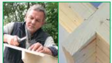
Optimale Auflage der Dachbretter durch abgeschrägte Seitenwandbohle
