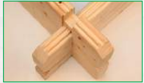
Winddichter Eckversatz
