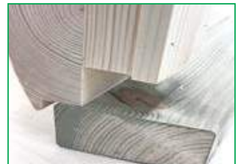
Wandelement auf imprägniertem Rahmen, schützt die Hölzer der Kota vor Witterungseinflüssen
