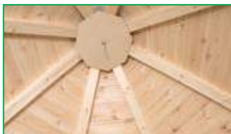
Innenansicht Dach (de luxe)
