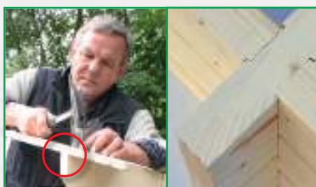
Optimale Auflage der Dachbretter durch abgeschrägte Seitenwandbohle
