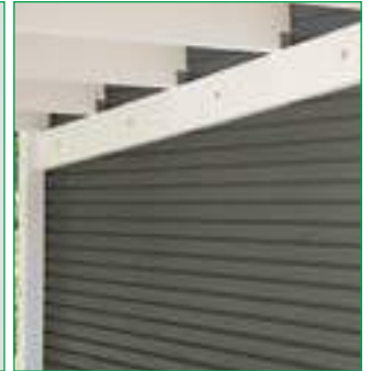
Stabile Dachkonstruktion bei den Seitendächern
