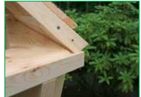
Stabiler Dachkranz / Dachauflage
