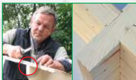
Optimale Auflage der Dachbretter durch abgeschrägte Seitenwandbohle
