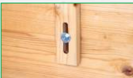
Sturmleisten sichern das Dach
