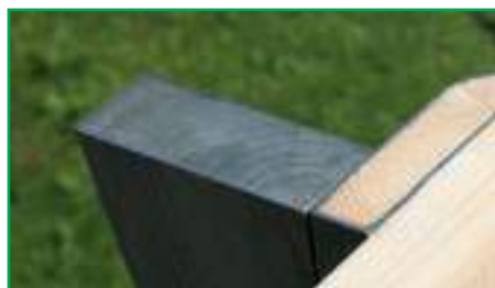
Große, stabile Auflage für den Dachkranz
