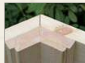
Kota/Pavillons-Eckverbindung 45 mm Bohle
