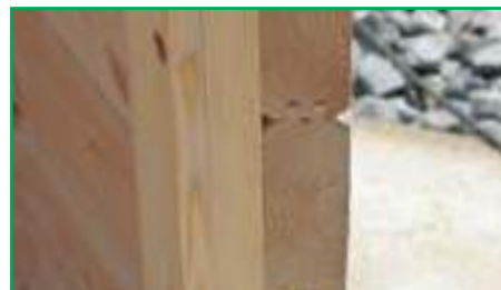
Massive 45 mm Wandelemente aus Lapplandkiefer auf Rahmenhölzer geschraubt
