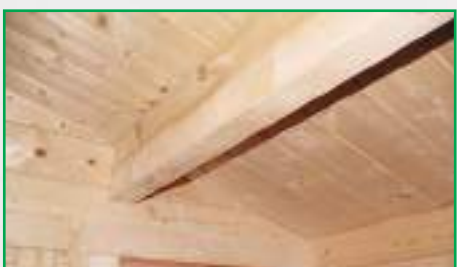
Stabile Dachpfetten; Dachbelastbarkeit über 180 kg/m 2
