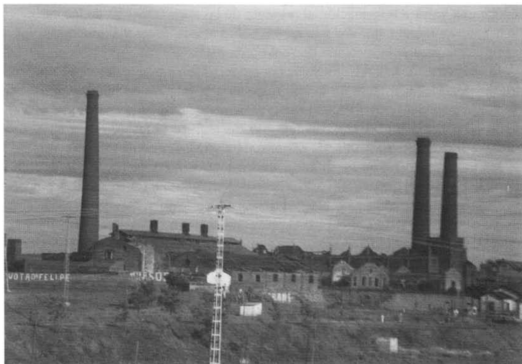
Vista parcial de las ruínas del que fue gran complejo industrial, derivado de la minería, en la «Cuenca carbonífera de Belmez (Córdoba)». Año 1997.
