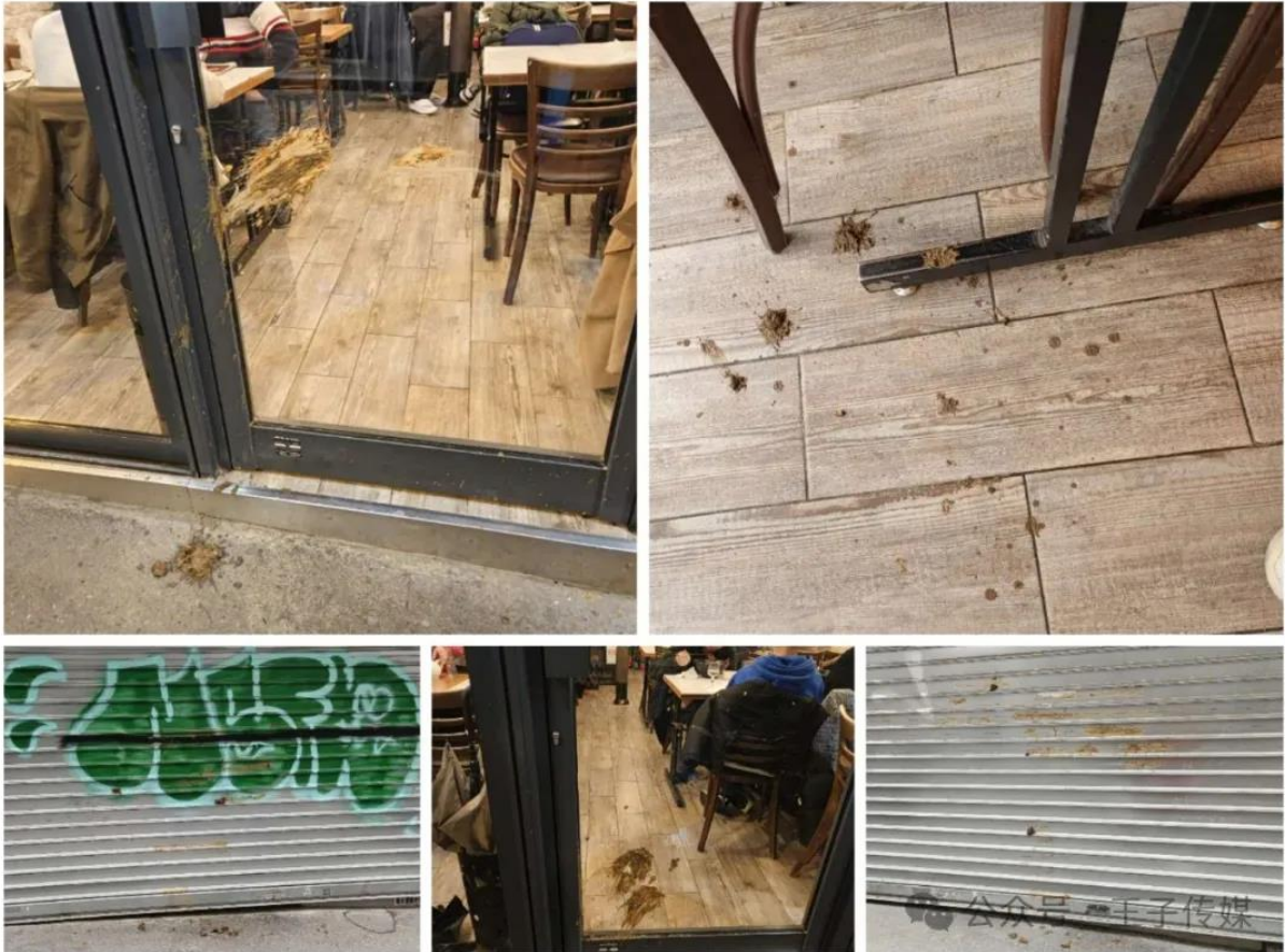
Porte et restaurant endommagés par Ling Huazhan.
