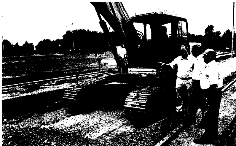
Die Zentrale Sportanlage wird derzeit auf neuesten Stand gebracht. In der neuen Saison wird sie den Herxheimer Sportlern wieder zur Verfügung stehen.
