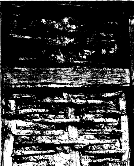
Stefan Flick ist bekannt für seinen sensiblen Umgang mit historischer Bausubstanz. Nur sparsam wurden und werden neue Materialien verwendet. Alle intakten Fächer mit Riegel und Lehmwickel werden belassen.
