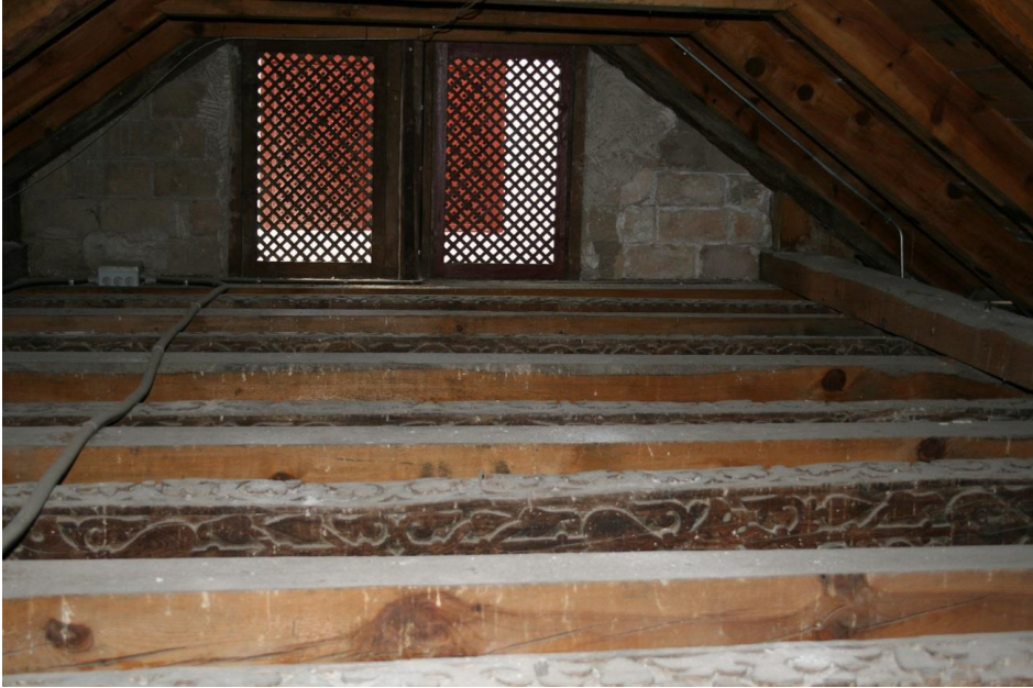
Interior de la cubierta de madera en la Mezquita-Catedral
