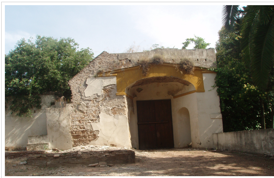
Foto nº 5 Interior de la puerta N. del convento
