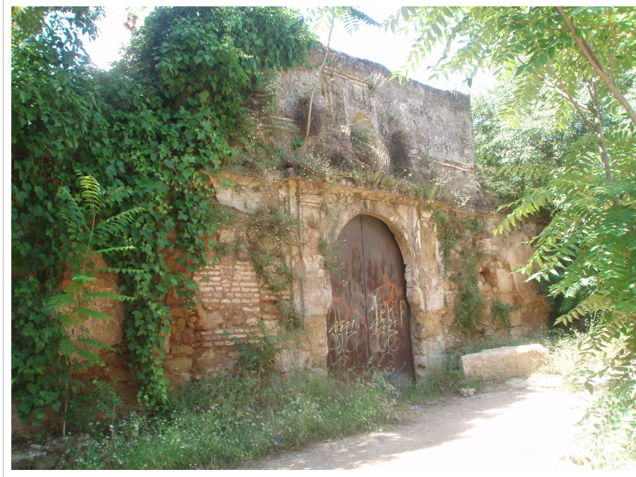
Foto nº 4 Puerta N. del convento
