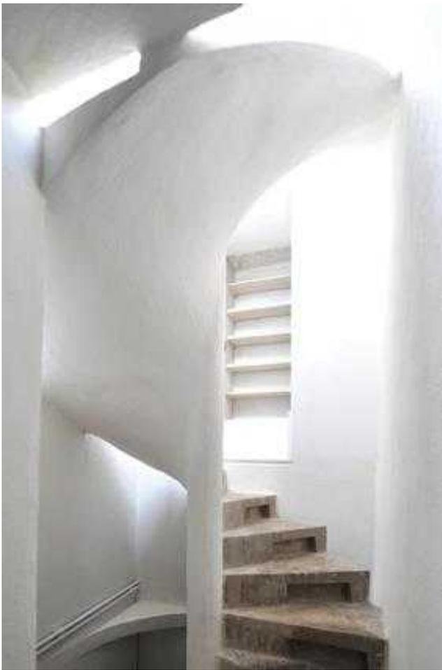
Un escalier en spirale permet de passer du rez-de-chaussée et la chambre de la domestique à l'étage, on remarque les entailles dans les marches qui permettaient d'y insérer les pieds et donc de faire des marches plus étroites.
