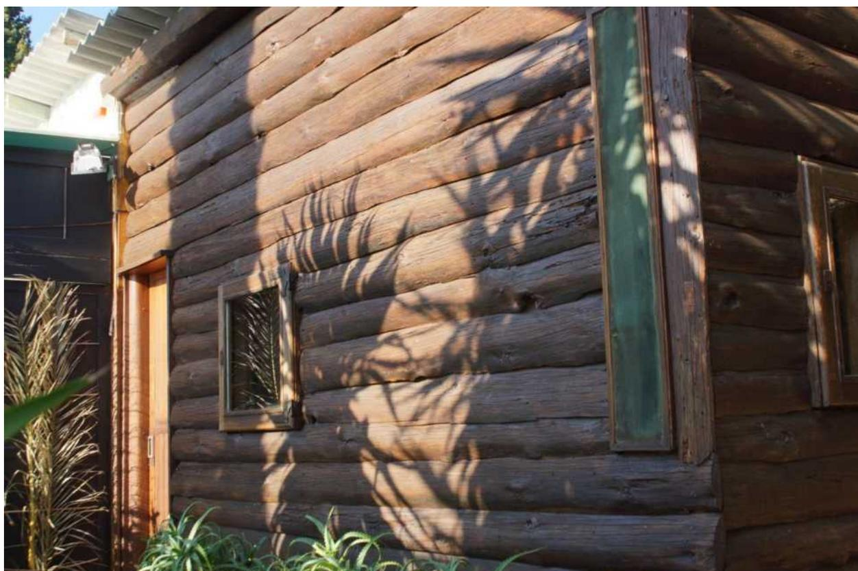
La construction du cabanon mêle le fait artisanal et l'industriel. Le Corbusier confia la construction du Cabanon à son ami le charpentier Charles Barbéris qui la réalisa dans son atelier en Corse. Les panneaux et les éléments structuraux arrivèrent par train et furent déchargés, grâce à un arrangement particulier, directement depuis les voies ferrées jusqu'au site.
