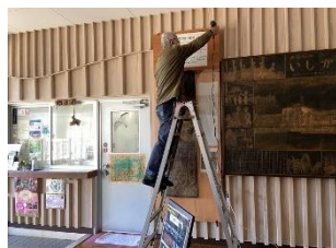
1階ねじを交換高所作業
