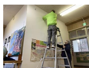
金具高所作業
