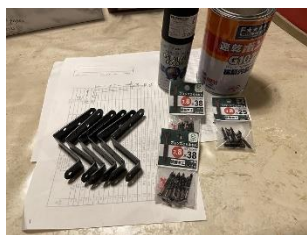
ボード取付金具製作
