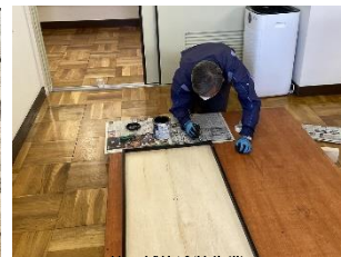
枠の補修塗装作業
