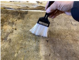
スプレー前に飛び散った泥を除去
