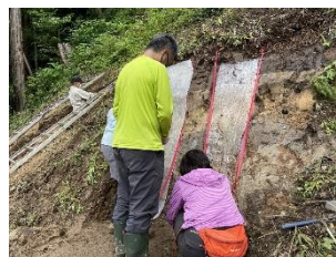
8/25 トマック塗布後寒冷紗貼り付
