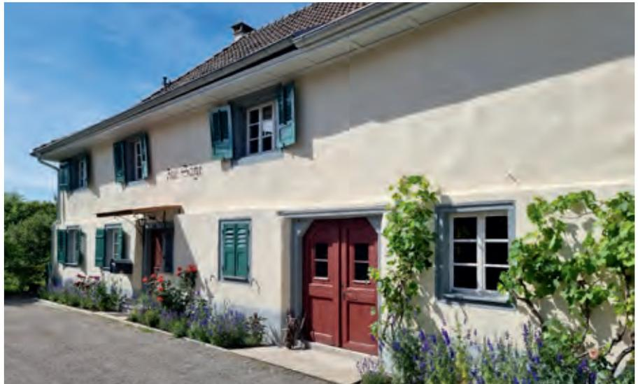
*Zur Säge in Buch: alles in Kalk von Putz bis zur Farbe.*
