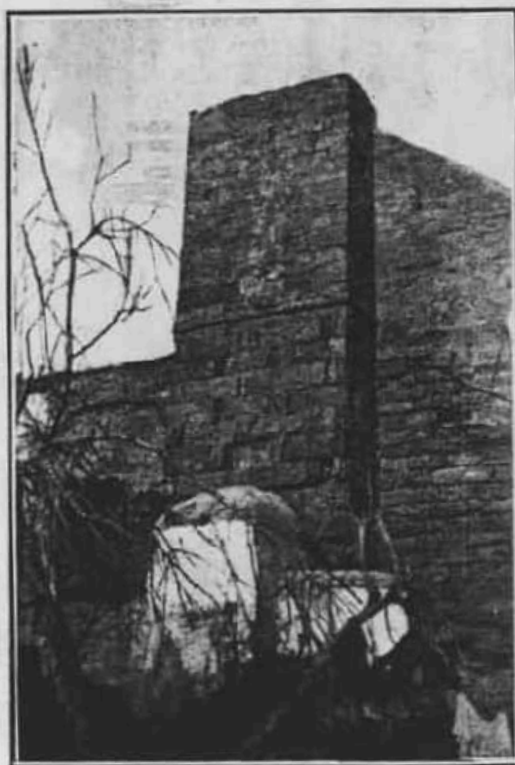
Torreón de muralla en la Huerta del Rey, cuya mitad inferior es de construcción califal.
