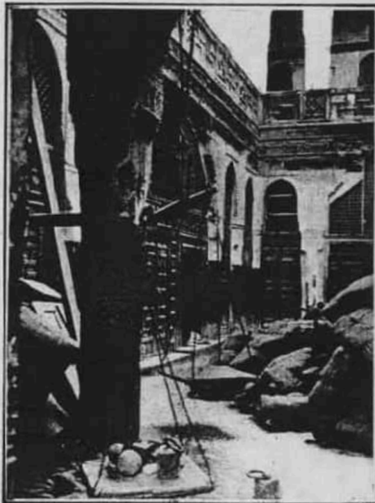
FEZ.—interior de un «fondak» en el barrio de los andaluces.
