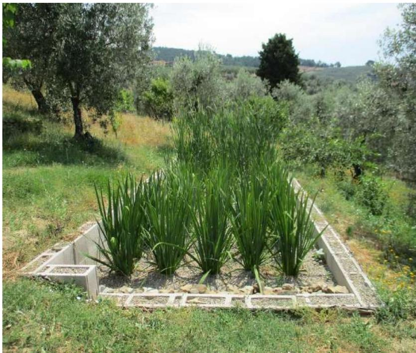
Fig. 7 – La vasca di fitodepurazione che alimenta due stoccaggi dai quali diparte una linea di irrigazione (foto dell'autore).
