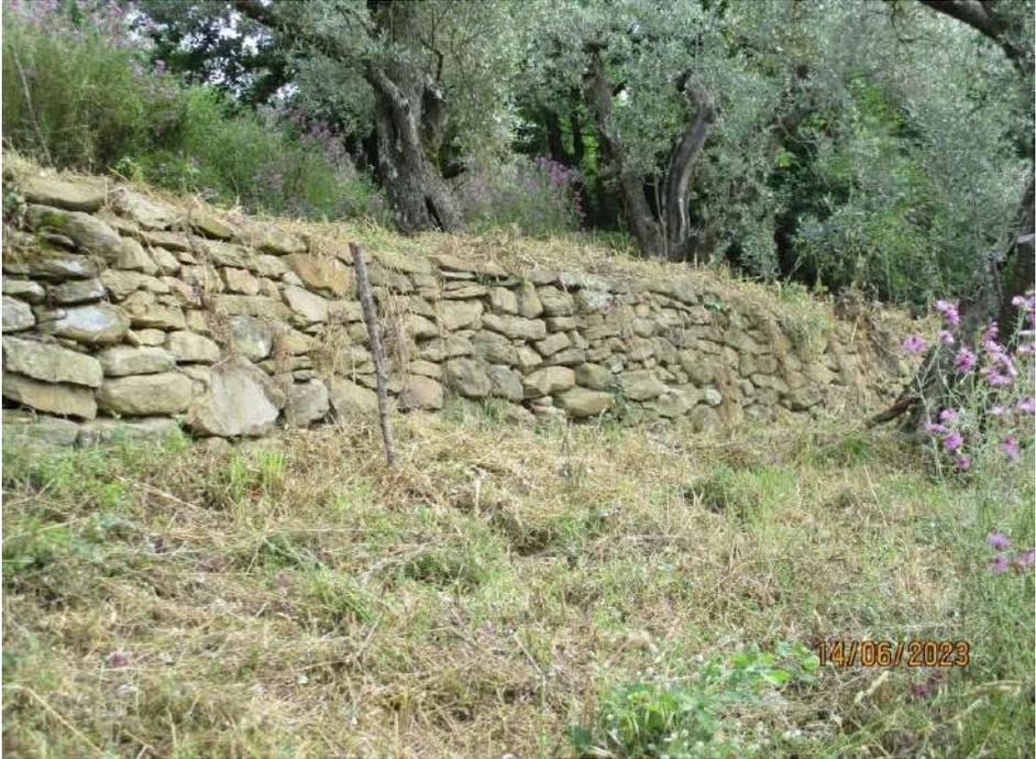
Fig. 10 – Muri a secco ricostruiti con le pietre recuperate dai franamenti (foto dell'autore).
