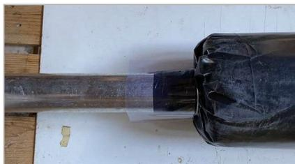
**32.** Schrumpf-Folie über die untere Seite stülpen bis sie den Körper der NHS berührt und Schritt 31. wiederholen. *Retourner le film rétractable sur la partie inférieure jusqu'à ce qu'il touche le corps de la SHN et répéter l'étape 31.*
