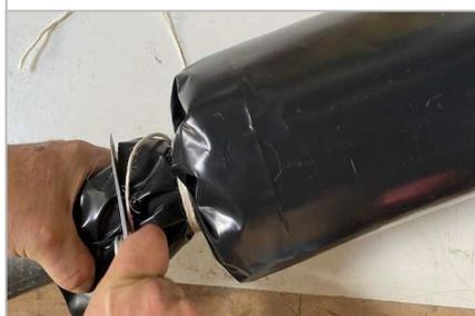
**25.** Überschüssige Folie und Bänder mit ca. 4 cm Abstand abschneiden (z.B. mit Messer als Hilfsmittel). *Couper l'excédent de film et de ruban à une distance d'environ 4 cm (p. ex. avec un couteau comme aide). Cut off excess foil and ribbons with a gap of approx. 4 cm (e.g. with a knife as an aid).*
