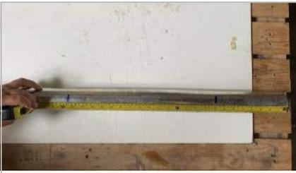
**1.** 20 cm und 60 cm am Rohr markieren. *Marquer 20 cm et 60 cm sur le tube.*
