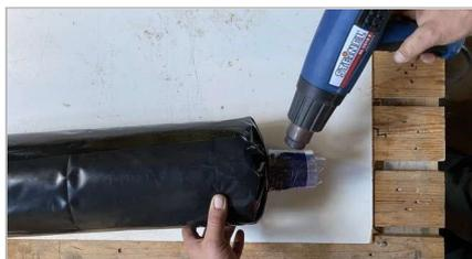
**31.** Schrumpf-Folie mit einem Föhn anföhnen, bis sie sich fest um das Gewebeband/Rohr gelegt hat. *Sécher le film rétractable à l'aide d'un sèche-cheveux jusqu'à ce qu'il soit bien fixé autour de la bande de tissu/du tube.*
