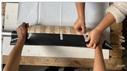
**20.** Folie unter die NHS legen und die Kante mit 3x Klebestreifen fixieren (oben, mittig, unten). *Placer le film sous le NHS et fixer le bord avec 3x bandes adhésives (en haut, au milieu, en bas). Place foil under the NHS and fix the edge with 3x adhesive strips (top, middle, bottom).*
