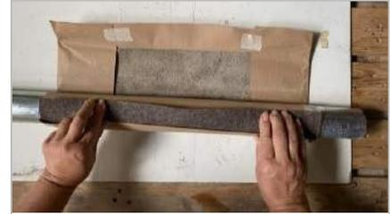
**12.** Papier wieder zuklappen und mit dem Filz wie bei Schritt 7. fest um das Rohr wickeln. *Replier le papier et l'enrouler fermement autour du tube avec le feutre comme à l'étape 7.*
