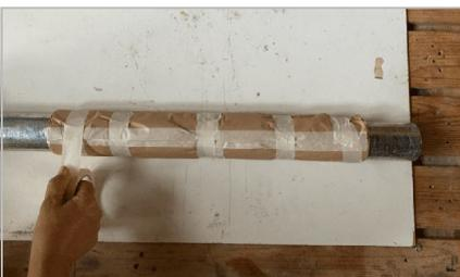
**13.** Papier mit Klebestreifen 1x längs festkleben und 4 – 5x fest um das Rohr kleben. *Coller le papier 1x dans le sens de la longueur avec une bande adhésive et le coller 4 - 5x autour du tube.*
