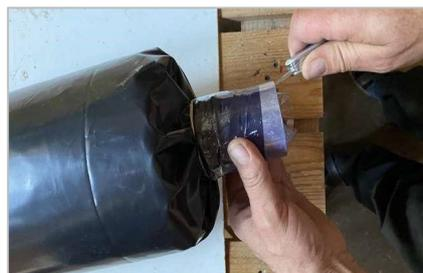
**33.** Überschüssige Schrumpf-Folie an der oberen Seite rundum abschneiden. Dafür den inneren Rand des Rohres als Leitlinie nutzen (z.B. mit Messer als Hilfsmittel). *Enlever l'excédent de film rétractable sur le côté supérieur. Couper tout autour. Pour cela, utiliser le bord intérieur du tube comme ligne directrice. (par ex. avec un couteau comme aide).*
