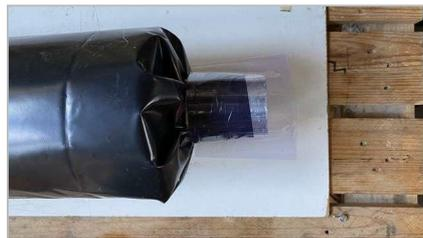
**30.** Schrumpf-Folie über die obere Seite stülpen bis sie den Körper der NHS berührt. *Retourner le film rétractable sur la partie supérieure jusqu'à ce qu'il touche le corps de la SHN.*
