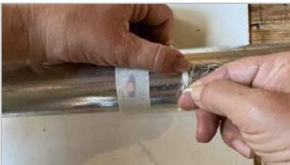
**4.** Umfang des Rohres messen (z.B. mit Seil als Hilfsmittel). *Mesurer le périmètre du tube (par ex. avec une corde comme aide).*
