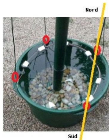
Unter das Rohr wird ein kleiner Stein gelegt, damit das Rohr vom Boden aus etwas Luft hat. *Une petite pierre est placée sous le tuyau ait un peu d'air par le bas.* Eine helfende Person hält das Rohr auf dem Stein möglichst mittig im Kübel und senkrecht. *Un assistant tient le tuyau sur la pierre, le plus au centre possible dans le bac et à la verticale.*
