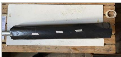
**22.** Folie mit 3x Klebestreifen fixieren. *Fixer le film avec 3x bandes adhésives. Fix the foil with 3x adhesive strips*
