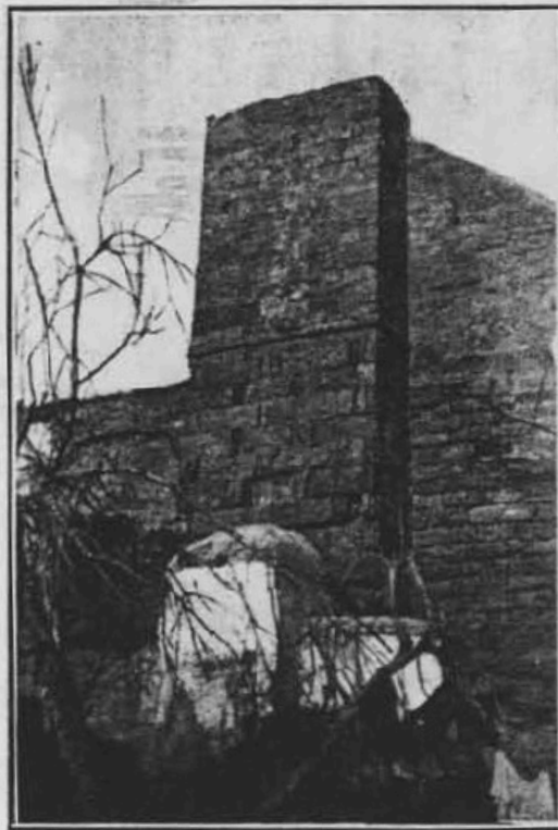
Torreón de muralla en la Huerta del Rey, cuya mitad inferior es de construcción califal.
