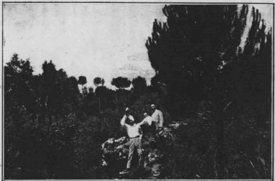
Restos del gran acueducto a su paso por el Arroyo de las Viejas.
