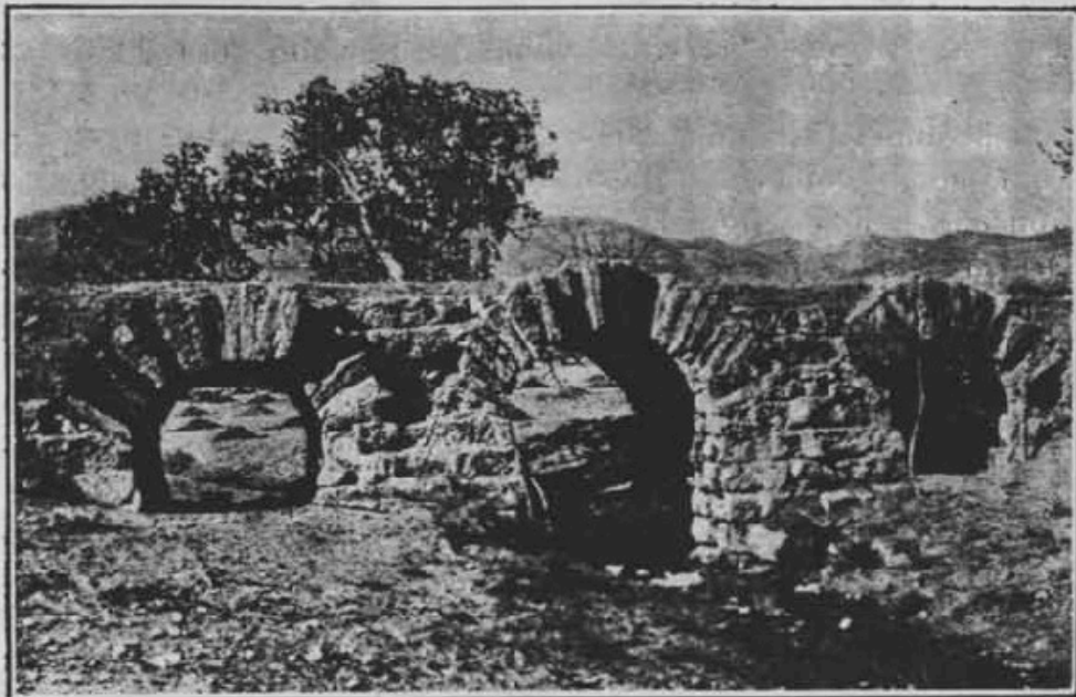
Puente califal, junto al cortijo de Los Nogales, en el camino de Medina Az Zahra.
