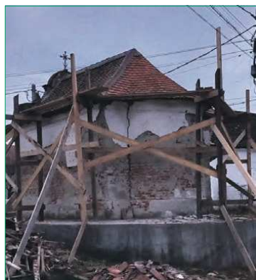
Die Arbeiten an der Wendelin-Kapelle gehen gut voran. Das Fundament wurde erneuert, der Dachstuhl wurde verstärkt und das Dach neu eingedeckt. Foto: P. Thelei
