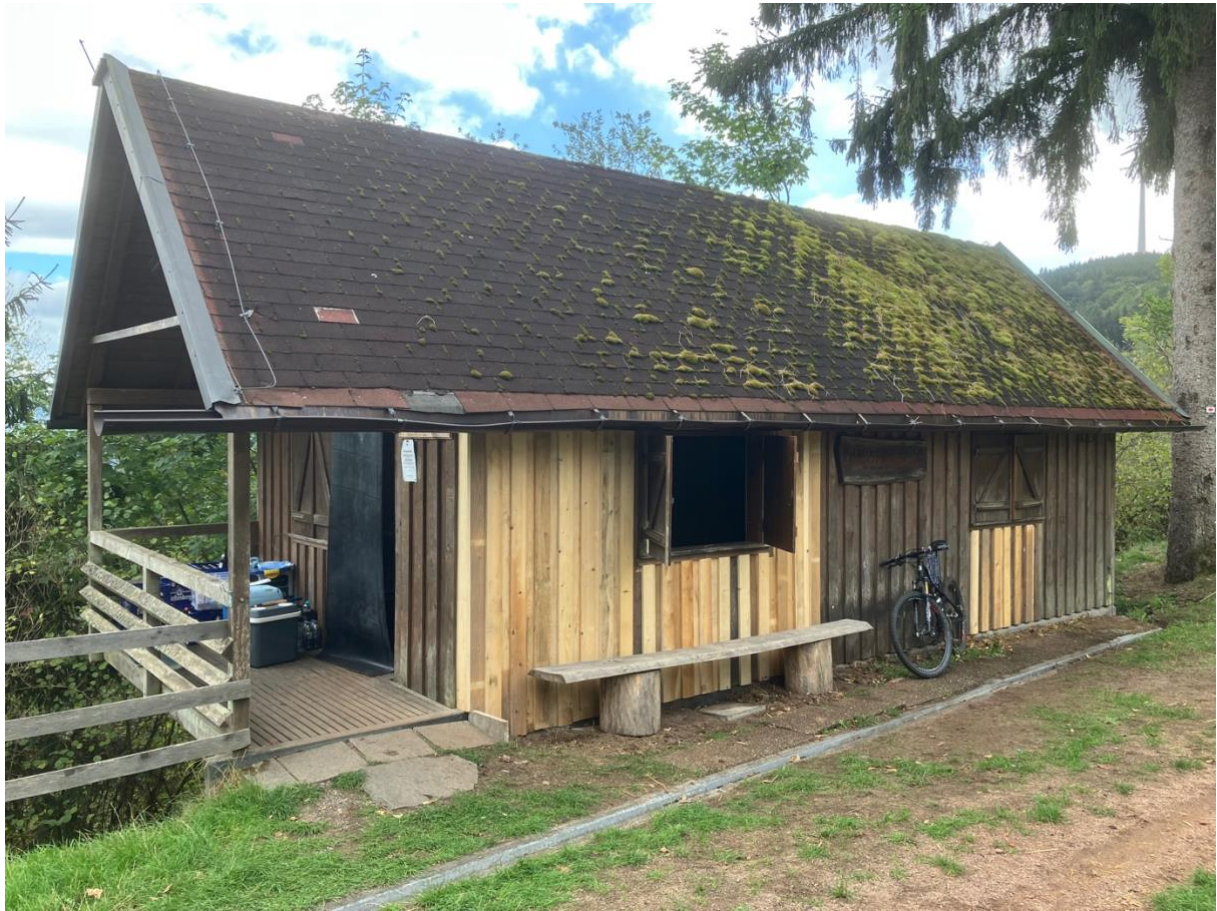
Die renovierte Fassade der Büchereckhütte (Foto: Lothar Gebele)
