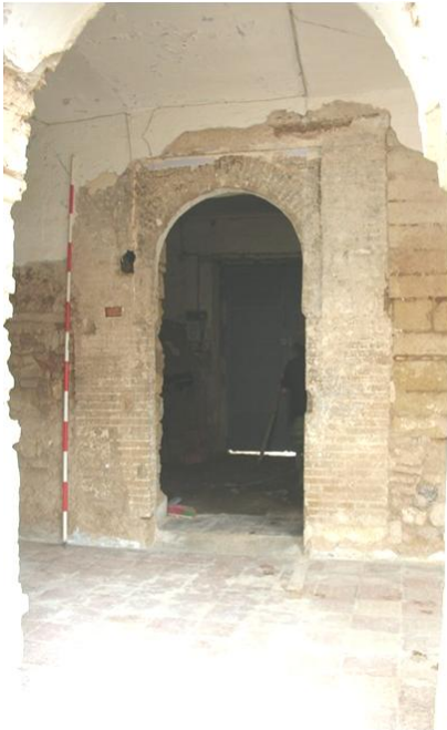
Fig. 1. Calle Moriscos n.º 28 (fotografía M. Martín)
