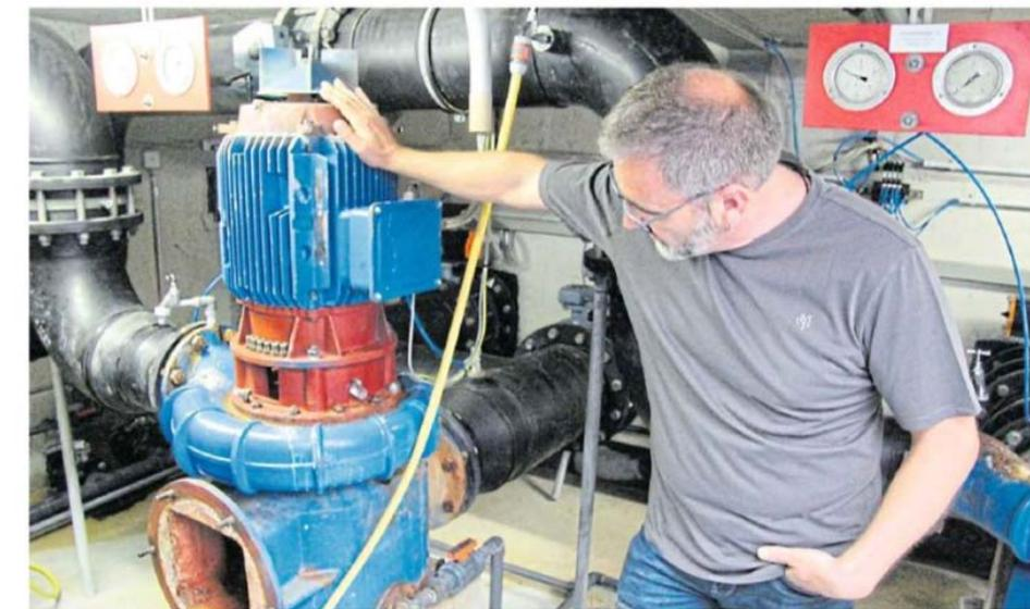
Schwimmeister Roberto Krierke zeigt das Herzstück der Freibadtechnik, eine der zwei großen Pumpen. Nachdem die gesamte Anlage bereits zweimal komplett unter Wasser stand, sind die Pumpen innerlich und äußerlich korrodiert und hinüber. Foto: Dieter Asbrock
