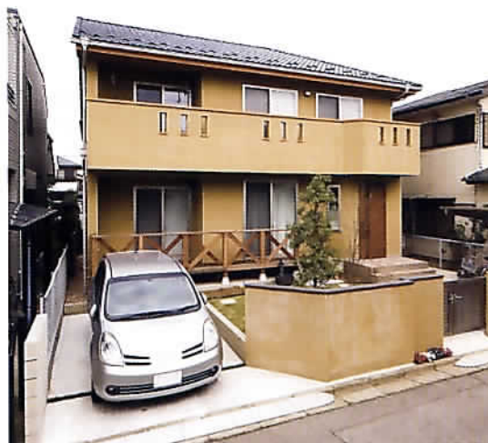
08 伝統工法「カキ落とし」の外壁 ◎こもだ建総
