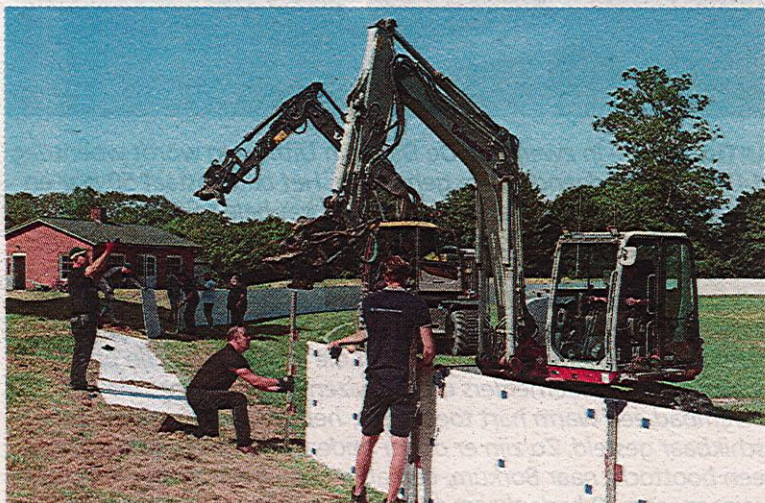
■ De opbouw van de grasbaan aan de Bosweg is in volle gang. Foto: Ronnie Afman.
