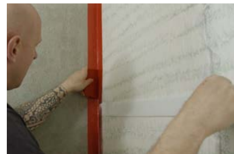
3. Eckdichtbänder anbringen
