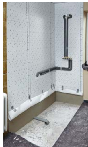
4. Leitungen installieren ggf. versetzen
