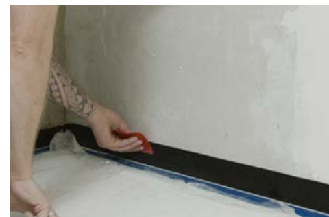
1. Wannendichtband verkleben
