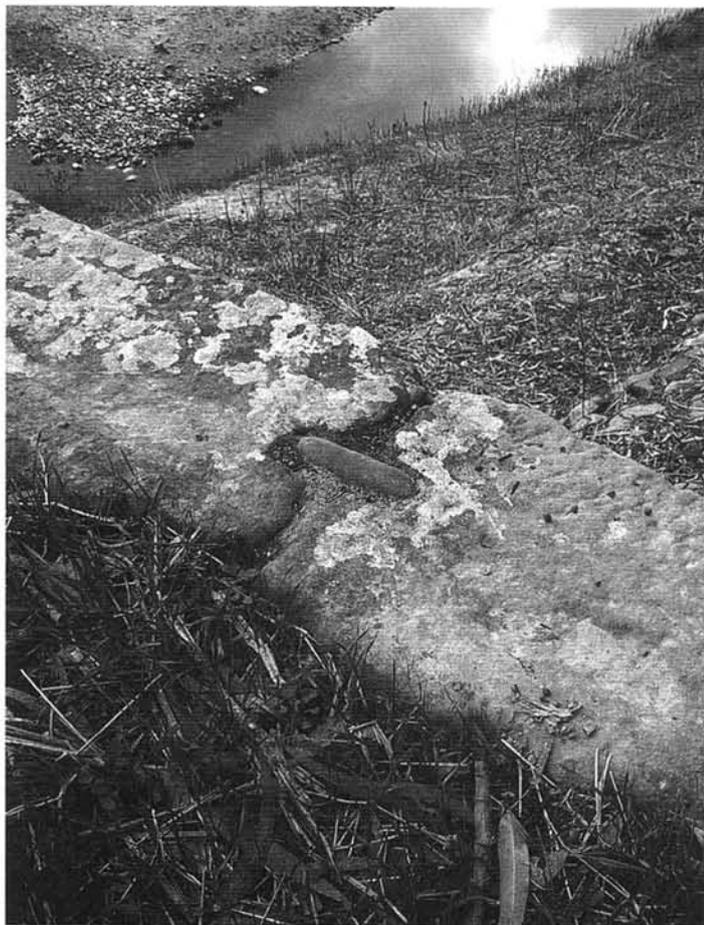
Como ya hemos señalado los sillares que conforman el pretíl de trabados, encontraban con “llaves” metálicas, no solo el la base de apoyo y sustentación, sino también entre sí, entre las caras superiores a fin de completar un arriostamiento perfecto.
