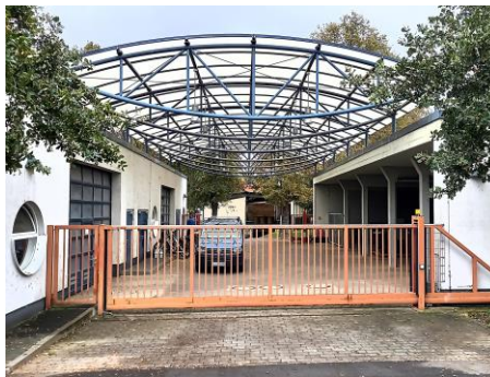
Ver- und Entsorgungsgebäude
