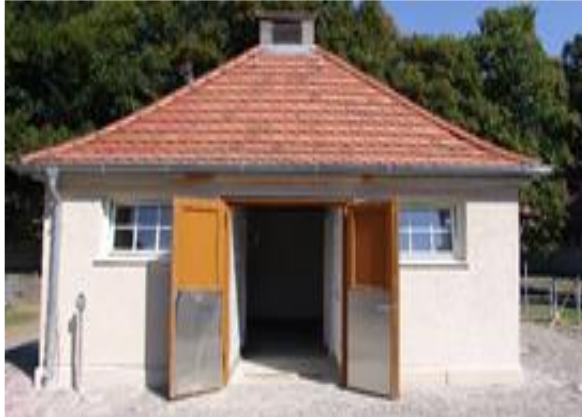
Umbau des ehemaligen „Dunghauses“ zu einem Kälberstall
