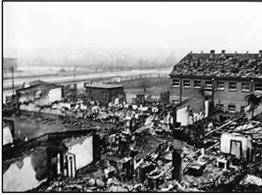
Kriegsschäden im Physiologiegelände
