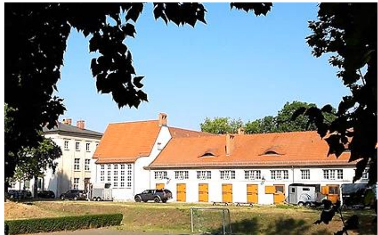
Fertiggestellter zweiter Klinikflügel - Pferdeabteilung
