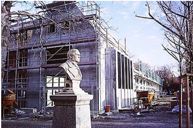
Neubau des zweiten Klinikflügels: Richtfest 1997
