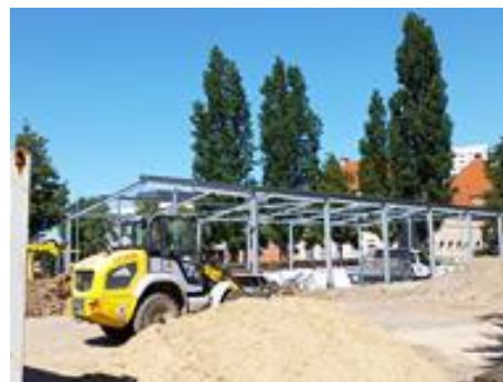
Bauplatz für eine Sektionshalle
