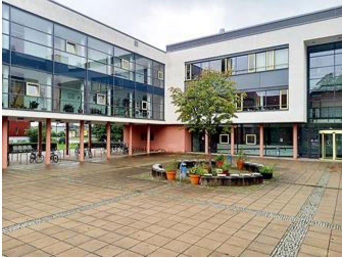
Veterinär-Physiologisch-Chemisches Institut im Obergeschoss - Innenhof
