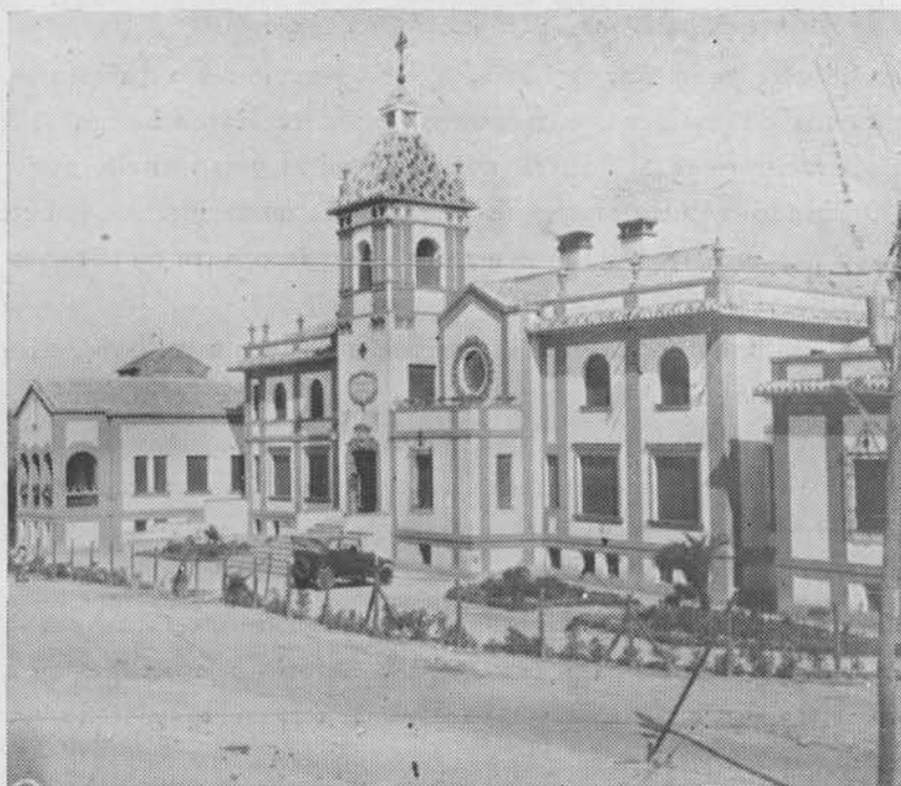
(Fig. 37). Hospital de la Cruz Roja. Vista de conjunto
