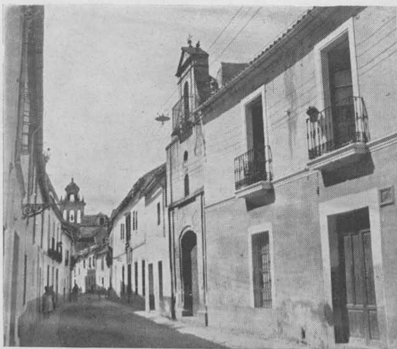
(Fig. 41). Hospital de San Martín en la calle Montero. Lo angosto de la calle obligó a tomar la fotografía muy de costado
