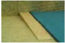
Druckfeste Gefälledämmplatte für die Wärmedämmung im Flachdach
