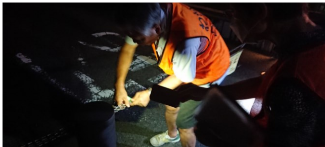
駐車場入り口の車止め開放・設置の確認
