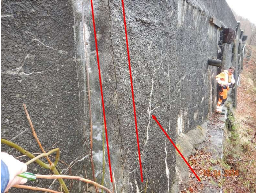
7524527_2016H_16-ROSTFAHNEN PFEILER SEGMENT 7
