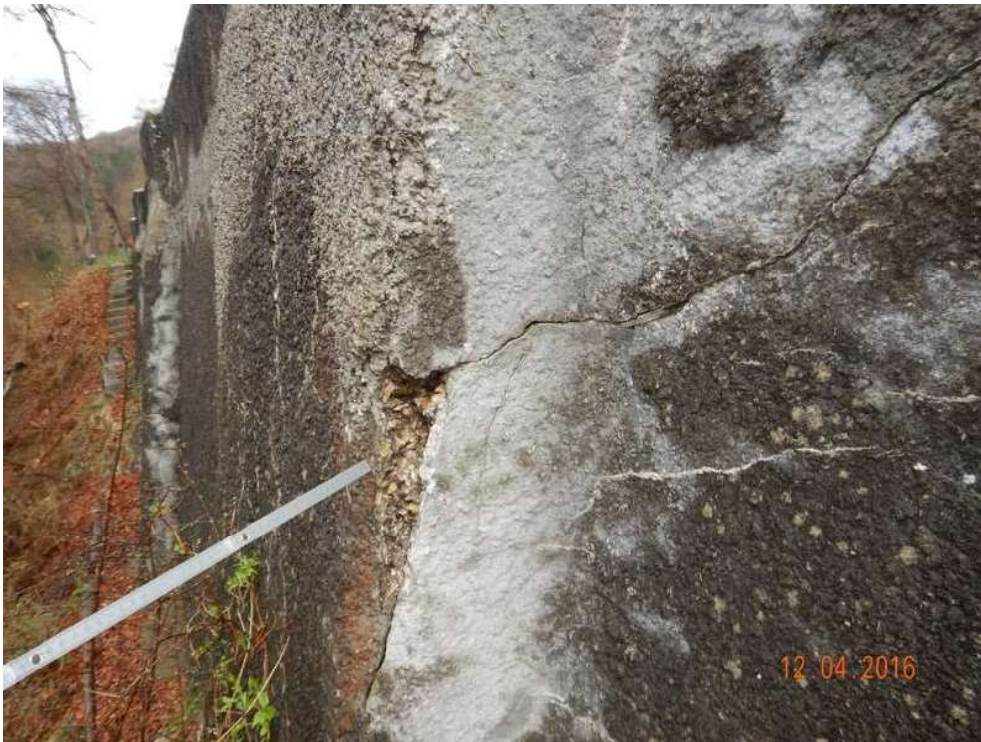
7524527_2016H_10 FEHLSTELLE VORPFEILER ZW SEGMENT 3 U 4
