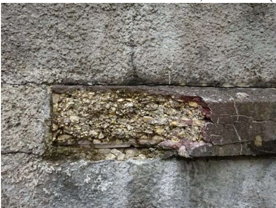
HP2021_ABGEBROCHENE STÜTZWANDABDECKUNG
