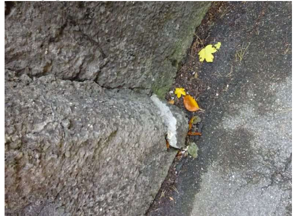
HP2021_LÄNGSFUGE SCHADHAFT
