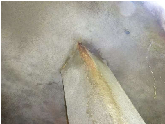
HP2021_ROSTFAHNEN PFEILERKOPF
