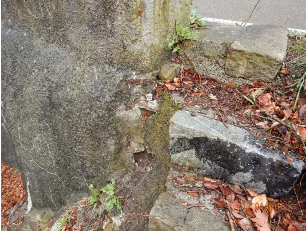
7524527_2016H_10 FEHLSTELLE VORPFEILER ZW SEGMENT 3 U 4
