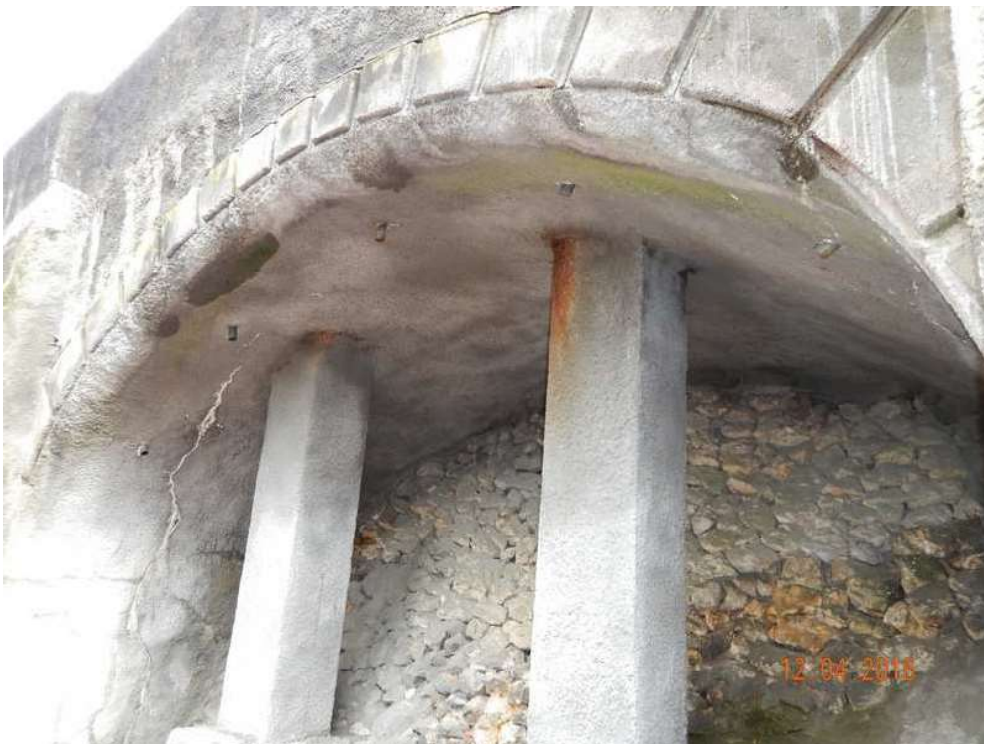
7524527_2016H_16-ROSTFAHNEN PFEILER SEGMENT 7
