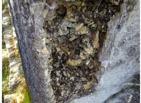
HP2021_ABPLATZUNG SPRITZBETON
