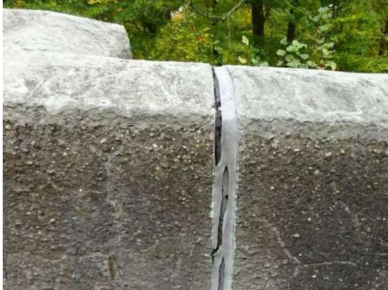
HP2021_FUGENFÜLLUNG SCHADHAFT
