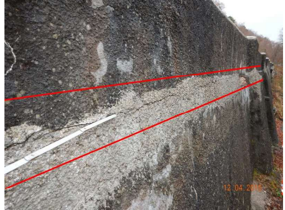
7524527_2016H_11-TRENNRISS BRÜSTUNG-STÜTZWANDKOPF DURCHGEHEND
