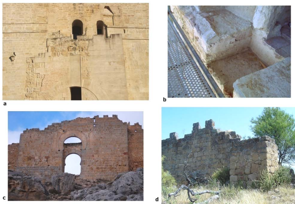
Figura 7.- Detalle de la merlatura que remataba la azotea de la puerta omeya: a.- vista general de los merlones conservados y restituidos; b.- detalle de los merlones, con restos de revestimiento blanco; c.- Puerta principal de la fortaleza de Gormaz; d.- Puerta Sur de la muralla de la ciudad toledana de Vascos.
