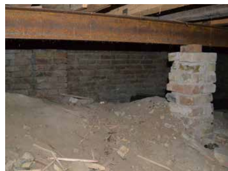
Provisorische Abstützungen der Kellerdecke
