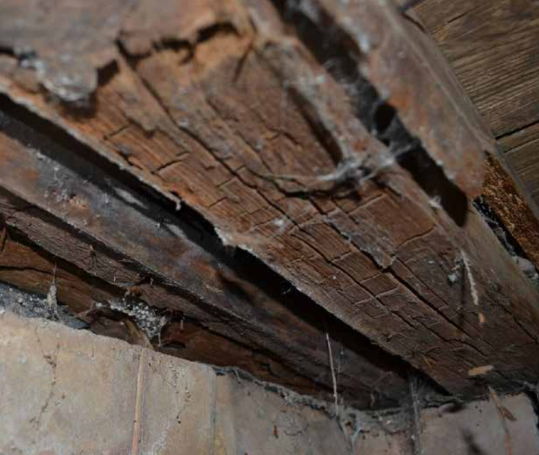
Mauerschwellen Kellerdecke
