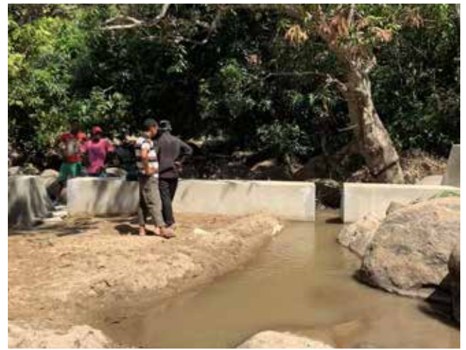
4) Barrage d'un ruisseau
