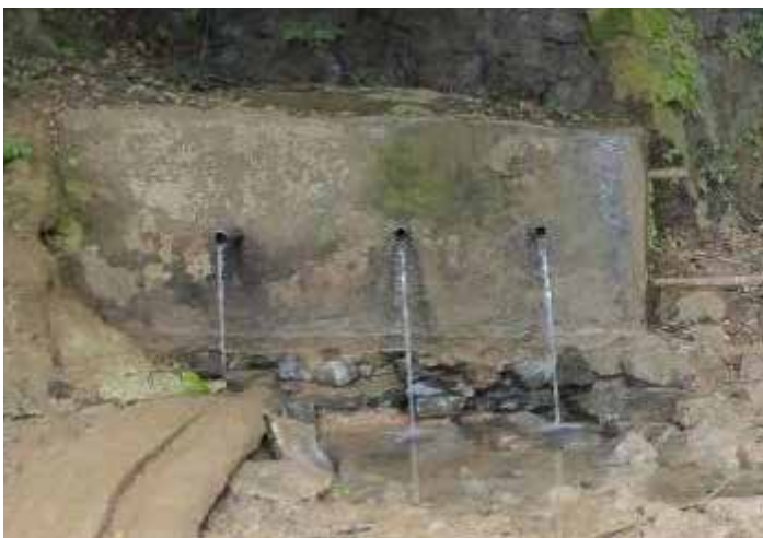
3) Captage d'une source
