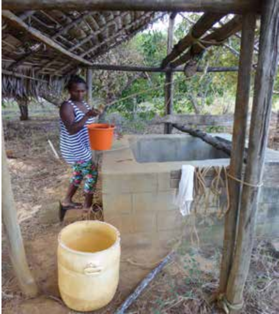
1) Puit creusé à la main
