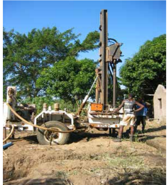
2) Forage pour les eaux phréatiques
