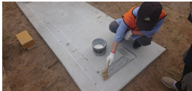
基礎コンクリートへの接着剤の塗布
