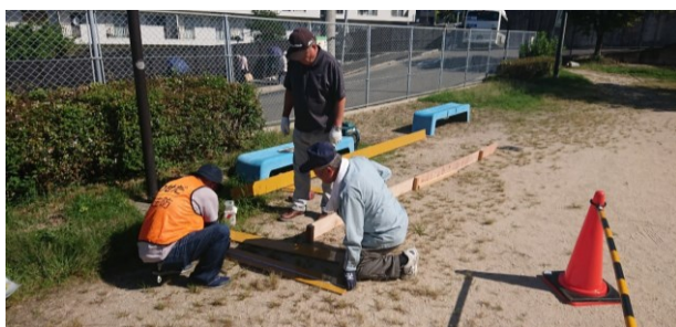
基礎コンクリートの型枠作り
