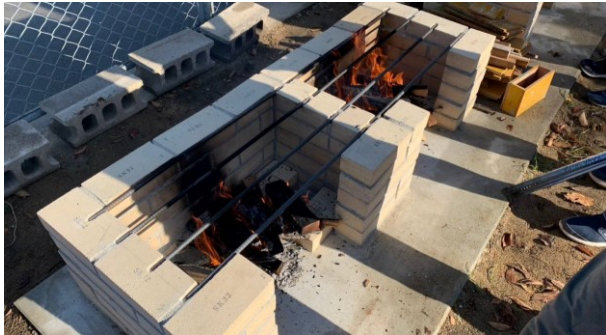
天板を取り外して火を入れたかまど
