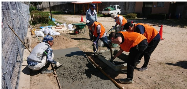
型枠内へのコンクリートの流し込み
