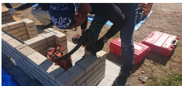
グリル設置のためのレンガの溝切り
