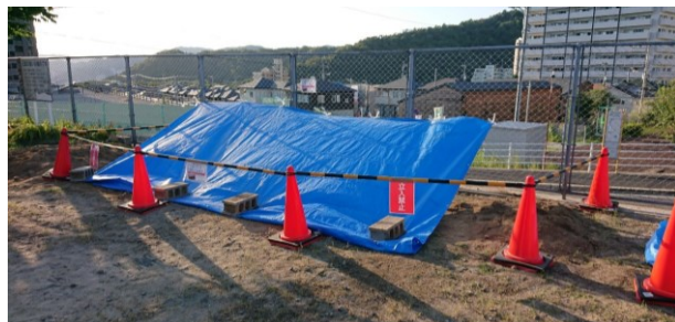
コンクリートの養生
