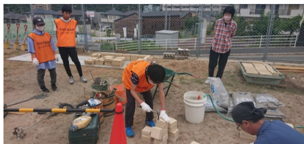
耐火レンガの半割り作業
