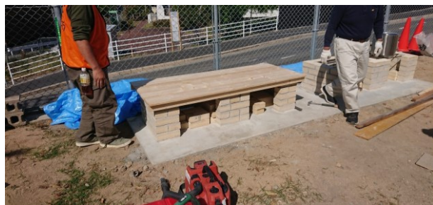
天板の設置・固定
