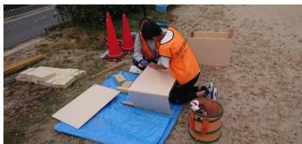
レンガを積むための型枠作り
