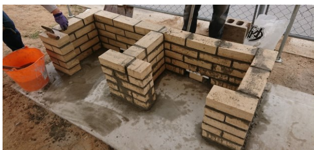
かまどベンチのレンガ積み完了
