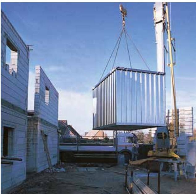
Mit 4 serienmäßigen Kranösen bis 3 Tonnen kranbar
