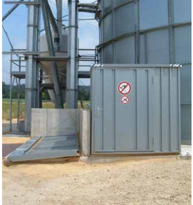
Einhausung für eine externe Schaltzentrale
