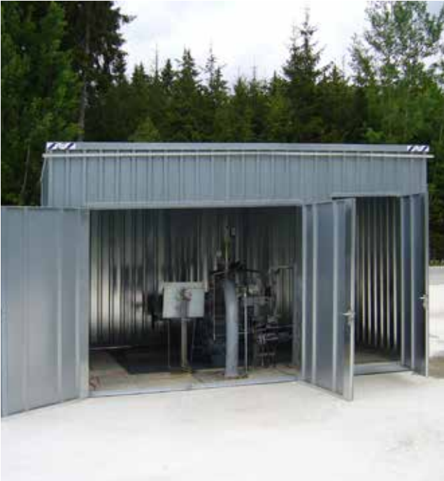
Einhausung von Gasförderanlagen
