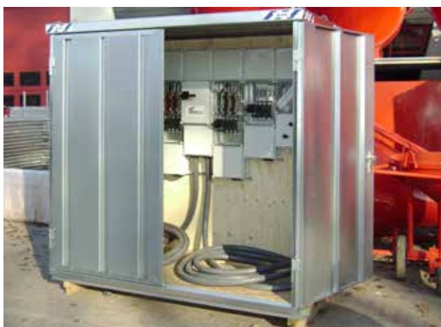
SC3000 als Einhausung für einen Stromverteilerkasten
