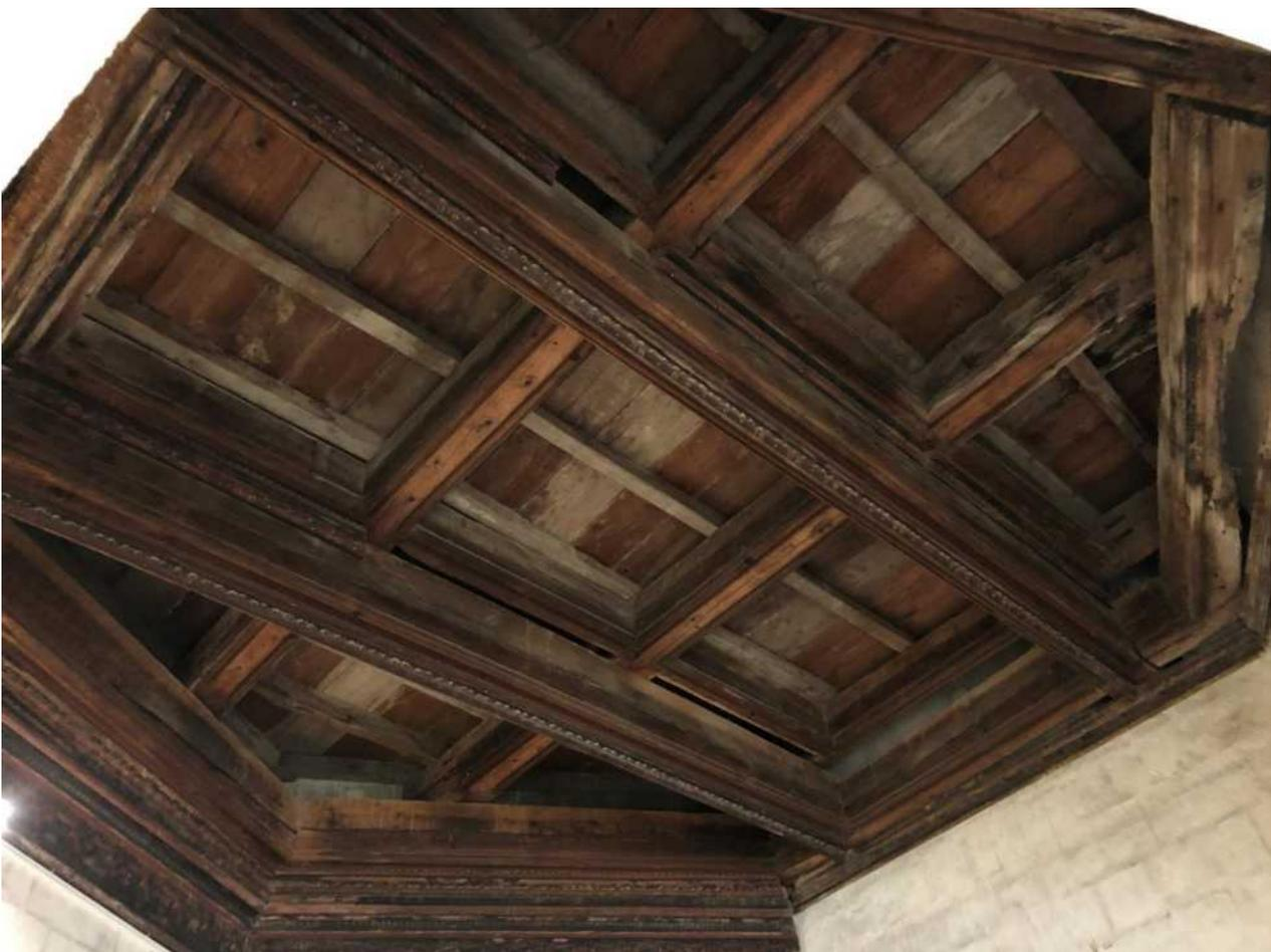
Le plafond de la chambre hexagonale non restauré permet de voir le type de construction de l'époque avec les grosses poutres en bois de mélèze qui arrivaient à Tarascon par voie fluviale.
