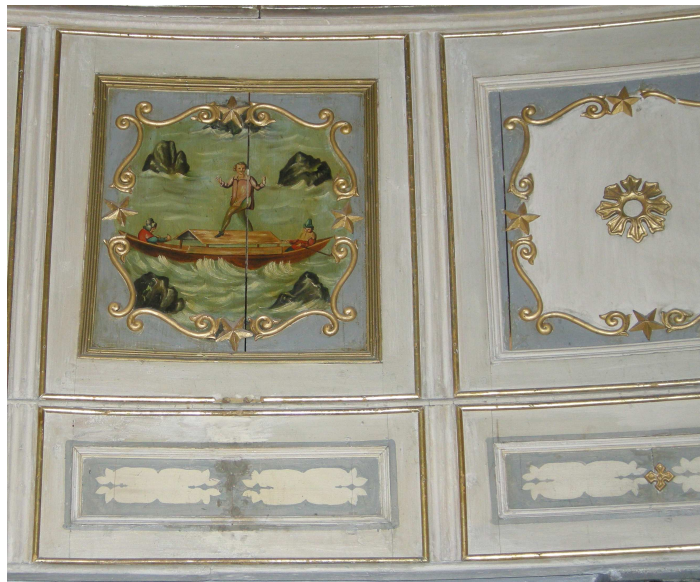
Abbildung 1: Blick vom Parterre auf die Galerie 18
