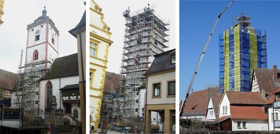
*Das Gerüst wächst und auch schweres Gerät kommt zum Einsatz. Inzwischen ist das abgebrochene Turmkreuz abgenommen und wird restauriert. Die Dachdecker-, Schreiner- und Steinmetzarbeiten in schwindelerregender Höhe an der Turmkuppel und am Ost-Chor haben begonnen.*
