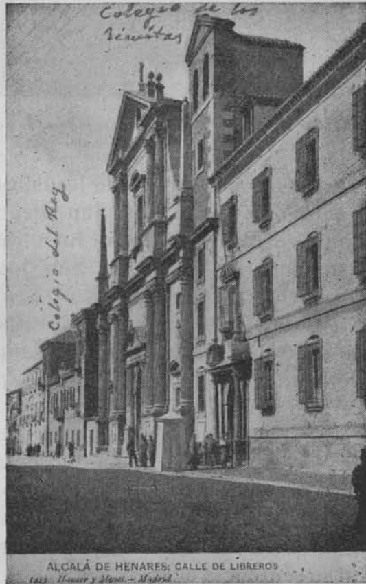
Hospital de la calle Libreros, en Alcalá de Henares
