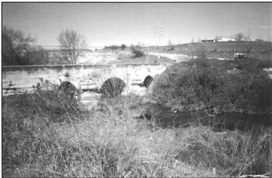
Foto nº 6.- Puente sobre el arroyo Gudalbarbo, camino de Armillat, antigua Vía Augusta.
