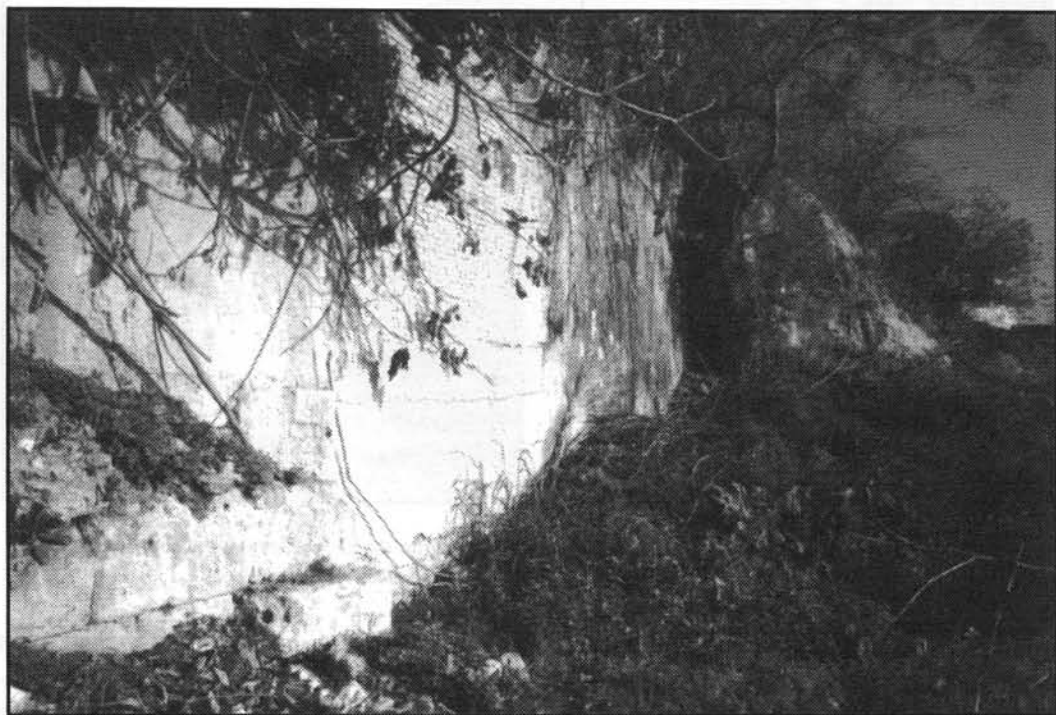
Foto nº 9.- Muralla existente en Las Quemadas, debajo de la terraza (Centro de Adaptación de Incapacitados Físicos (CAIPO)).
