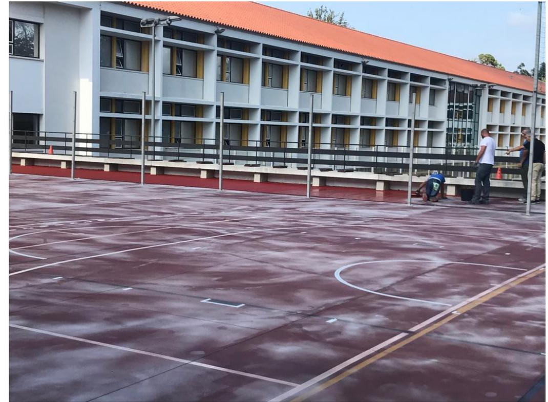
Aplicación a labio de goma de una primera (1ª) mano de **Slurry acrílico-110** en la totalidad de la superficie a tratar. 1.400 gr/m<sup>2</sup>
