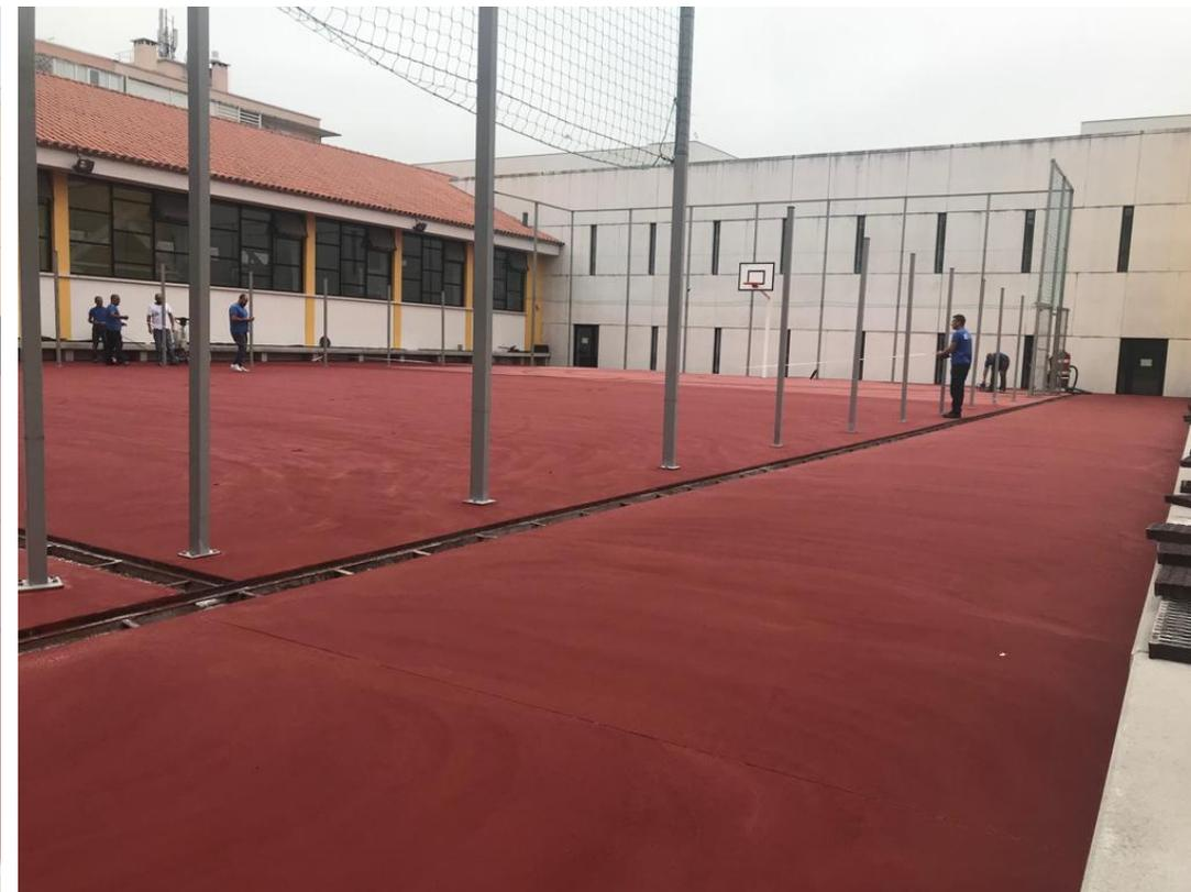
Aplicación a rodillo de demarcación de zonas con pintura **Sport Pistas-100** en la totalidad de la superficie a tratar. 350 -400 gr/m<sup>2</sup>. y marcación de señalización vial con pintura monocomponente para tráfico
