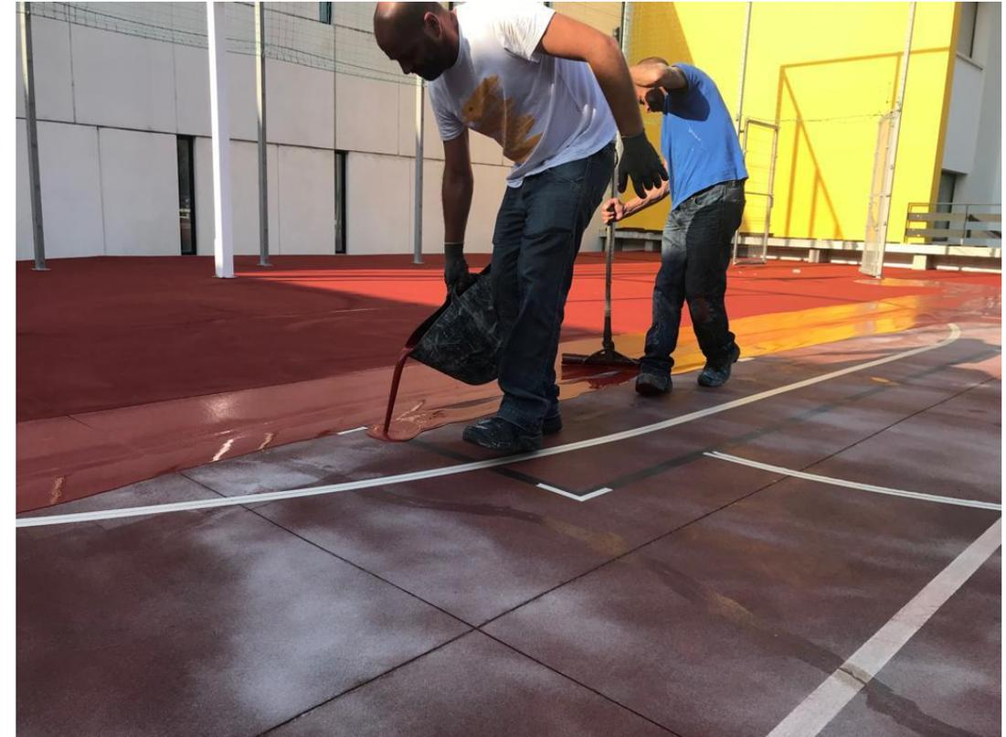
Aplicación a labio de goma de una segunda (2ª) mano de **Slurry acrílico-110** en la totalidad de la superficie a tratar. 1.400 gr/m<sup>2</sup>
