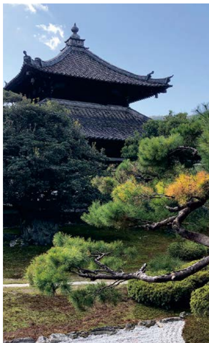
鹿王院の舍利殿（現在修復中）。 中に源実朝が宋から招来した仏牙舍利（釈 尊の齒）を安置する多宝塔がある。
