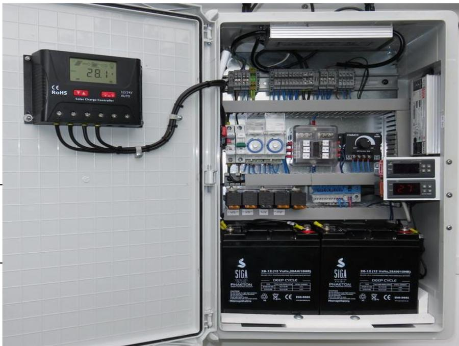
Schaltschrank mit Spannungsversorgung über eine Photovoltaikanlage 12V / 150Wp.
