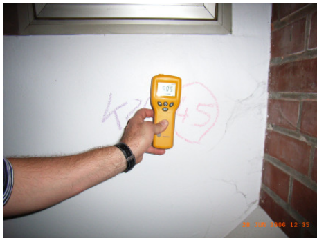
Bild 6, Ermittlung der Bauteilfeuchtigkeit an der Oberfläche (Foto aus anderem Vorhaben)
