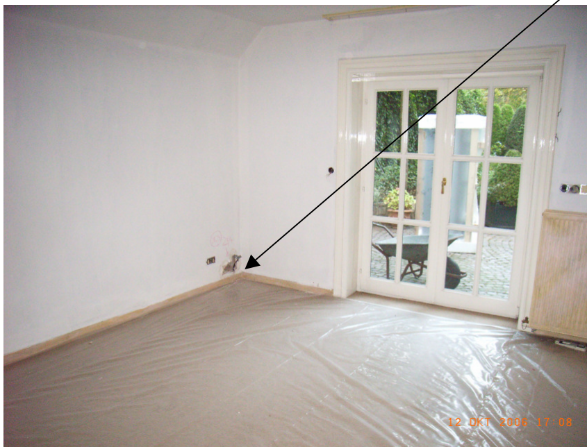
P:\Eigene Gutachten-Versuche\Kvarnström\Ordner für Fotoanlage IFR\3IFRRIMG8772.JPG
