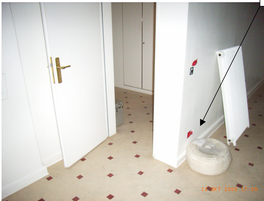
P:\Eigene Gutachten-Versuche\Kvarnström\Ordner für Fotoanlage IFR\5IFRRIMG8775.JPG
